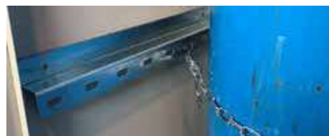
Catena di fissaggio bombole
