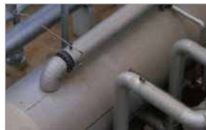
Lavaggi impianti di raffinazione
