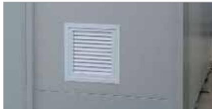
Aerazione naturale, a norme D.M. 18/05/95, con griglie in alluminio (NON REI) a lamelle fisse con rete antinsetto dimensioni pari a 1/30 della superficie in pianta, posizionate in modo speculare per un migliore ricircolo dell'aria.
