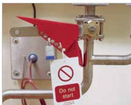
Il bloccaggio consente solo la posizione chiusa ad angolo retto per valvole con comando a leva. Da utilizzare assieme ad un lucchetto di chiusura.
