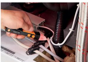
Primo controllo della tensione di alimentazione su un compressore.
