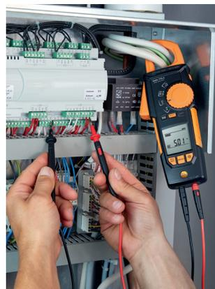
Misura della tensione sul quadro di commutazione di una pompa di calore con strumento di misura sospeso.
