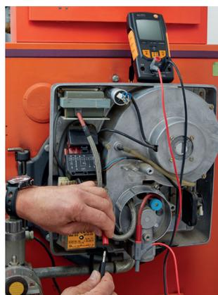
Misurazione della corrente di ionizzazione
